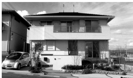
写真1 スマートエネルギーハウス
