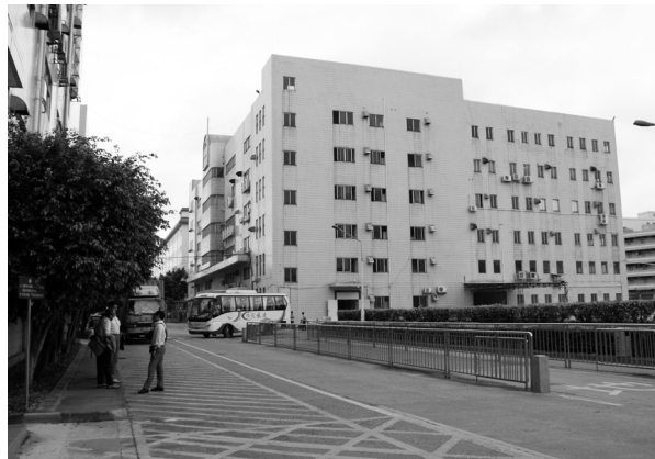
深圳テクノセンターの1号棟
