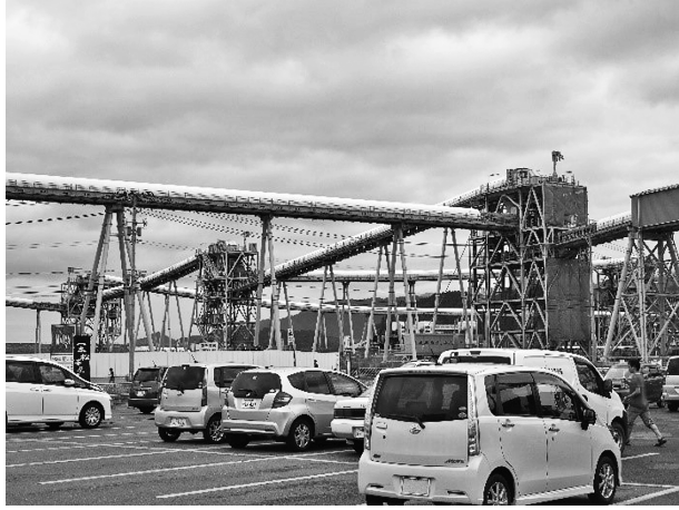
写真2 大規模な設備を用いた高上げ工事が進む陸前高田市 (2015年筆者撮影)
