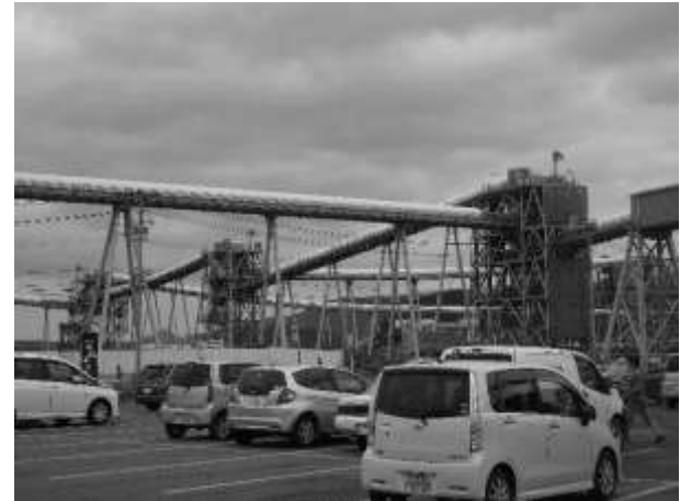
写真1：被災地における大規模な嵩上げ工事
