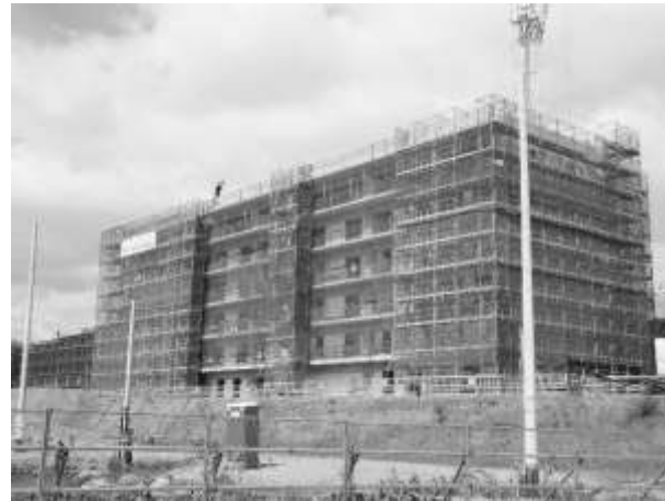
写真2：大手ゼネコンが建設中の災害公営住宅
