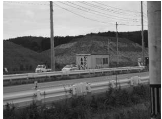
写真7：「なつかしい未来へ」と書かれたプレハブが建つ嵩上げ工事現場 ※宮城県南三陸町、2016年筆者撮影
