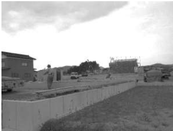
写真6：復興住宅の宅地造成の様子
